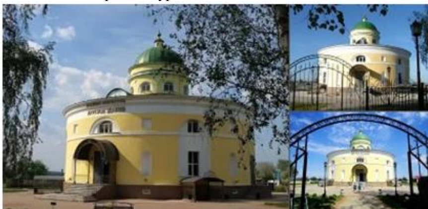
Рис. 5. «Круглое здание» в селе Головчино Fig. 5. «The Round building» in the village of Golovchino
